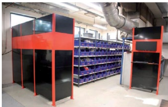
Projektiin kuului myös puolivalmisvaraston rakentaminen. Tilaan asennettiin Kastenin pientavarahyllystöt muovilaatikoineen.
