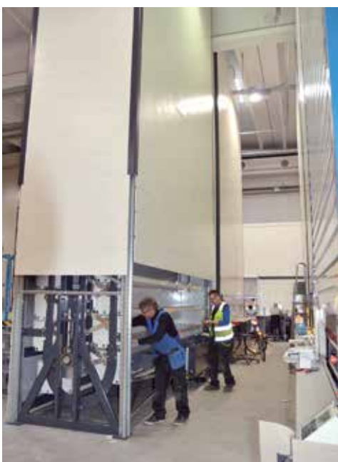
Uusinta Kasten Paterosteria asennetaan.
